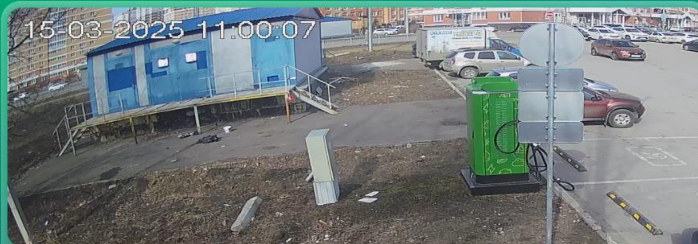
Безопасность трансформаторных подстанций
